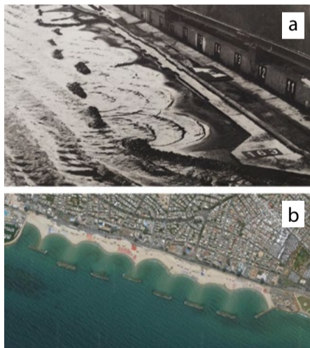
פרויקט אתרים שנבנה ב-1978: a - מודל פיזיקלי שבוצע במכון CAMERI ב-1973, b - תצלום אווירי של המצב העדכני בשטח אתרים בתל-אביב. התמונה באדיבות דוברות הטכניון
